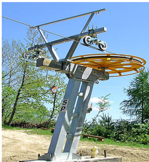
Rys. IV.2. Stacja przewojowa (źródło: http://www.elster.com.pl )
