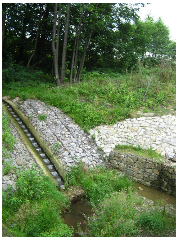
Fot. 8: Zbudowa potoku w rejonie ulicy Karbowej, stwarzająca przeszkodę w migracji płazów w kierunku północ-południe pomiędzy terenami „Gościnniej Doliny”, a północnymi zboczami Dębowca
